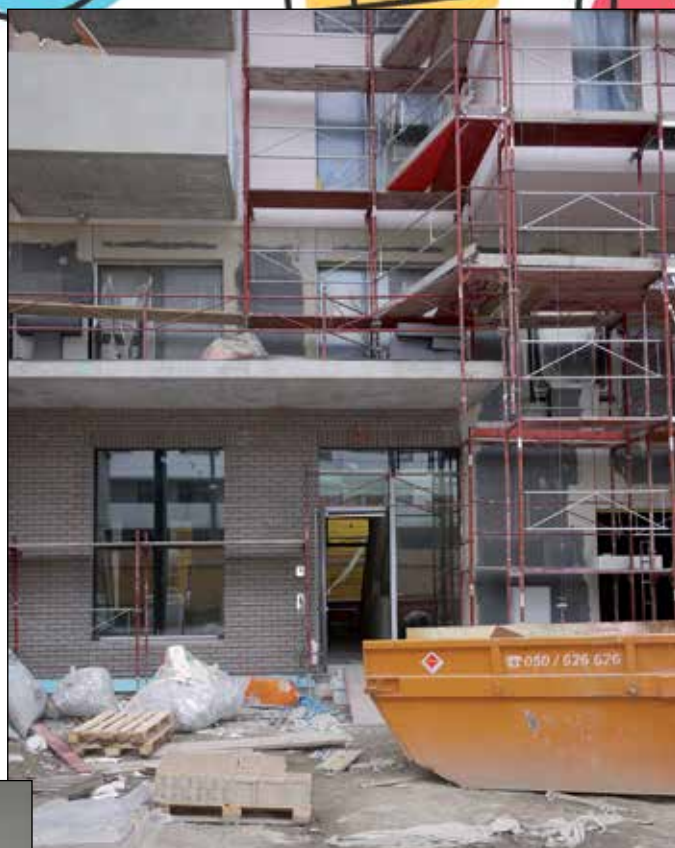
Bei unserer Begehung am 15. Juli 2021 fanden wir noch eine große Baustelle vor. Nun ist das Projekt kurz vor der Fertigstellung.
